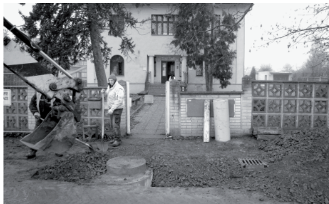
Oprava dešťové kanalizace před zdravotním střediskem
